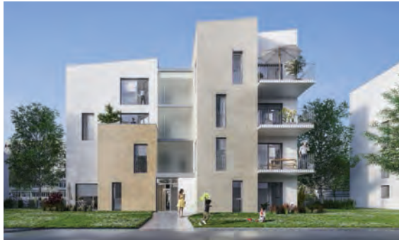
Construction 18 logements intermédiaires
