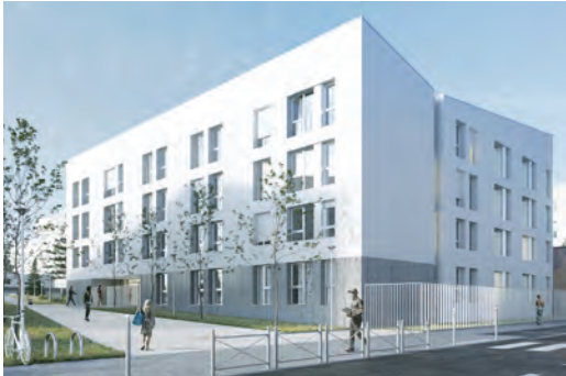
Construction d'une résidence étudiante de 90 logements
