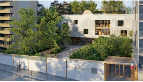
Construction école maternelle de 6 salles de classe
