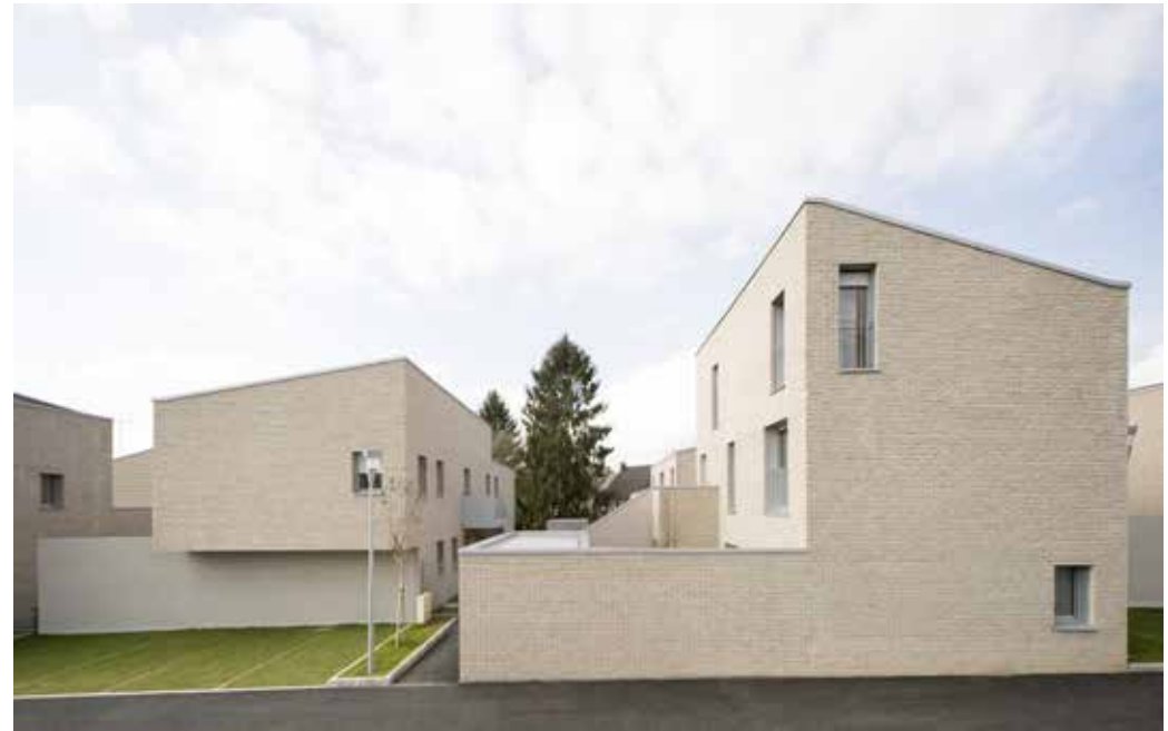
Vue d'un bâtiment depuis la voie d'accès
