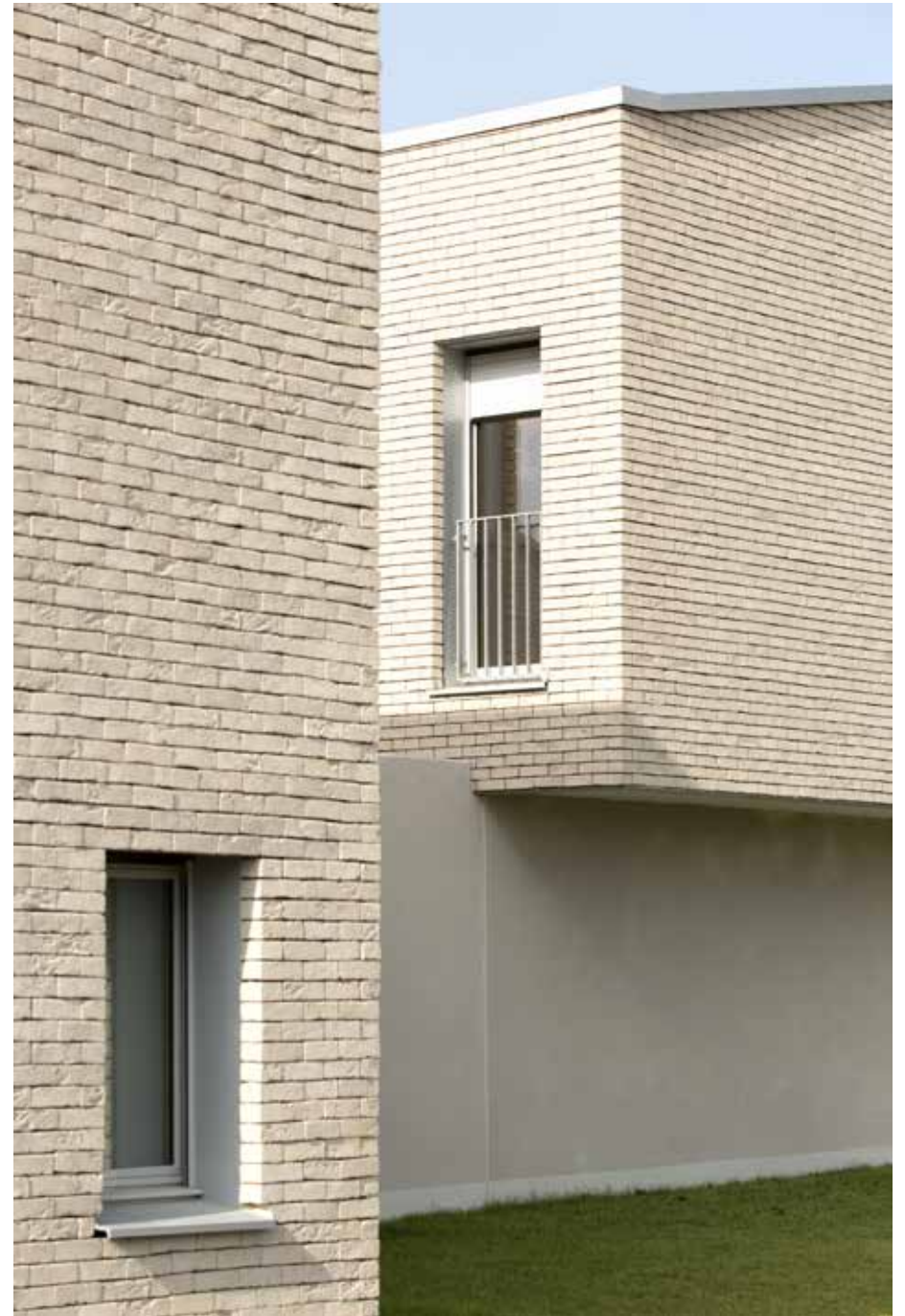
Vue du projet depuis la voie d'accès
