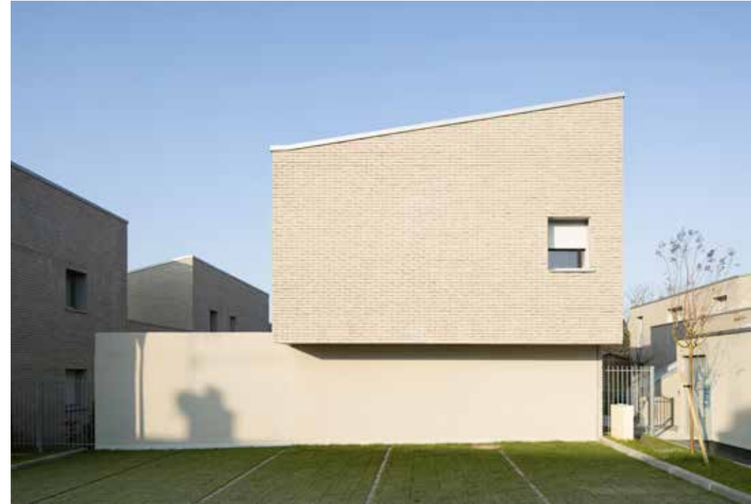
Vue d'un bâtiment depuis la voie d'accès
